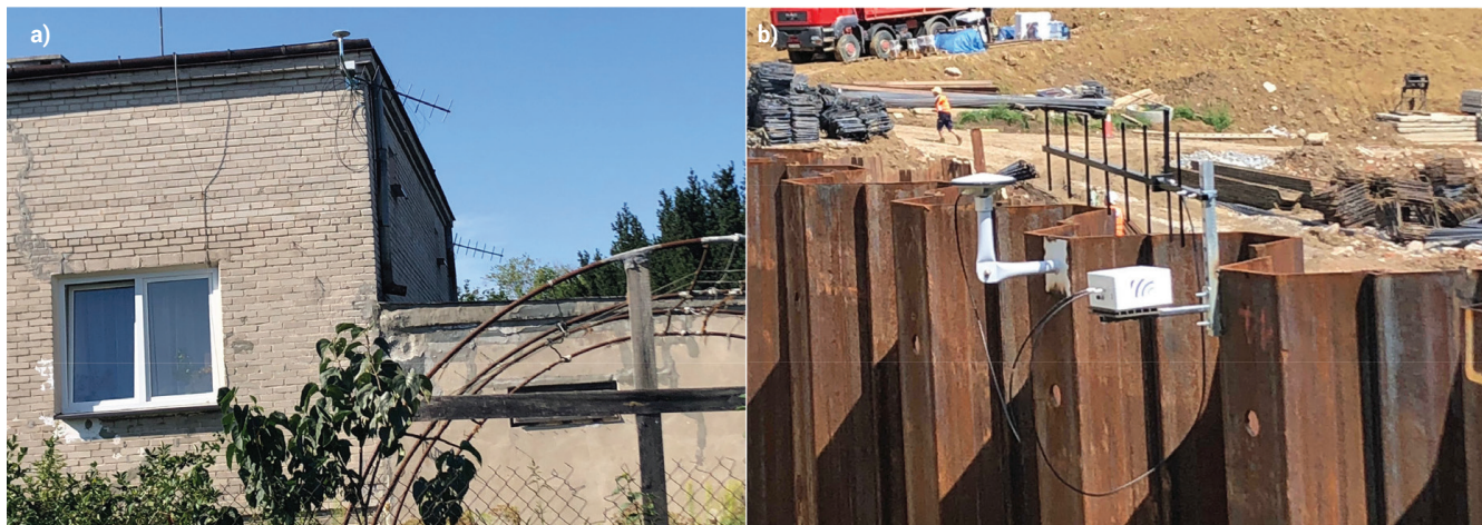
Rys. 6. Fotografia punktu pomiarowego zlokalizowanego a) na chronionym budynku b) na konstrukcji oporowej
